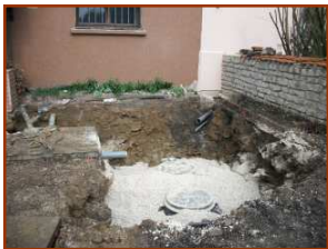
Pose d'une filière compacte - 5 EH (fosse toutes eaux + filtre à laine de roche)
