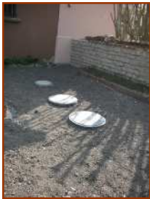
← Pose d'une fosse toutes eaux →
