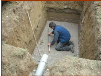
Pose d'une fosse toutes eaux
