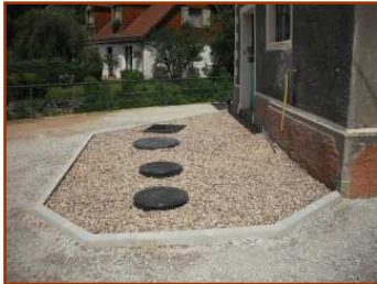
Installation d'une filière compacte
