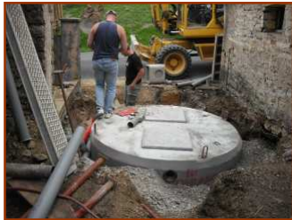
Pose d'une colonne de ventilation
