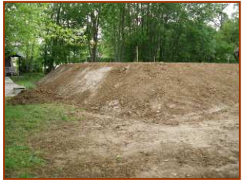
Création d'un tertre d'infiltration (50 m 2 )
