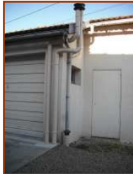
Pose d'une colonne de ventilation
