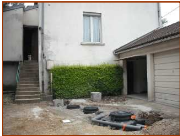
Pose d'une filière compacte - 5 EH (fosse toutes eaux + filtre à laine de roche)
