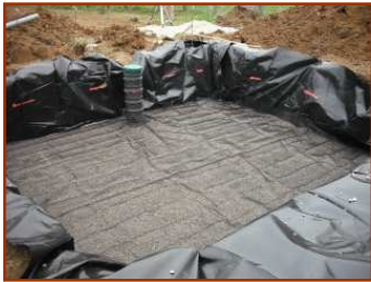
Création d'un filtre à sable de 25 m 2
