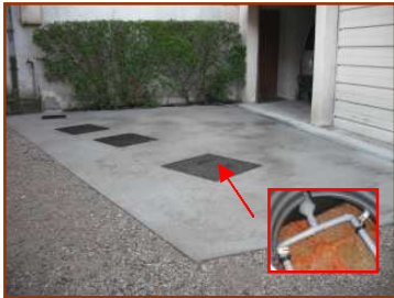
Pose d'une filière compacte - 5 EH (fosse toutes eaux + filtre à laine de roche)
